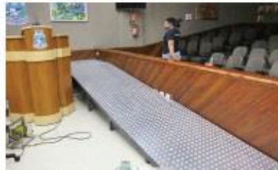
A rampa é uma das várias obras de reforma e adequação que estão em fase de conclusão na Câmara
